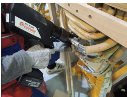
Crimpen mit der batteriebetriebenen Presswerkzeug Elpress PVX1300.
