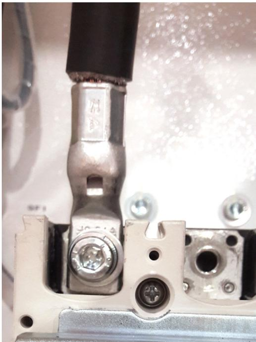
*Beim Anschluss bestimmter Komponenten wie z. B. Schaltanlagen können Kabelschuhe mit schmalen Anschlussflansch erforderlich sein.*
